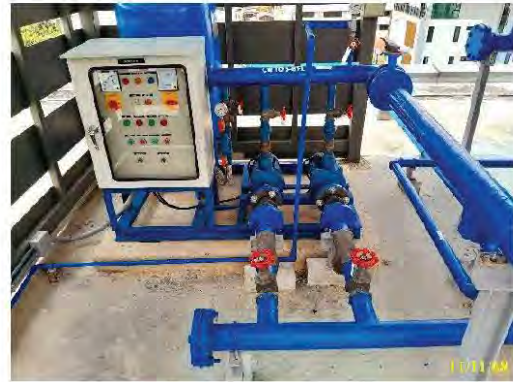
ถังสำรองน้ำใช้ชั้นดาดฟ้า พร้อมเครื่องปั๊มน้ำ
