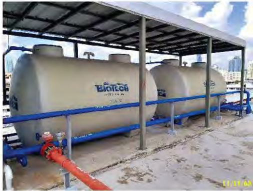
ถังสำรองน้ำใช้ชั้นดาดฟ้า พร้อมเครื่องปั๊มน้ำ
